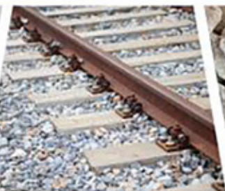
轨道材料检测
